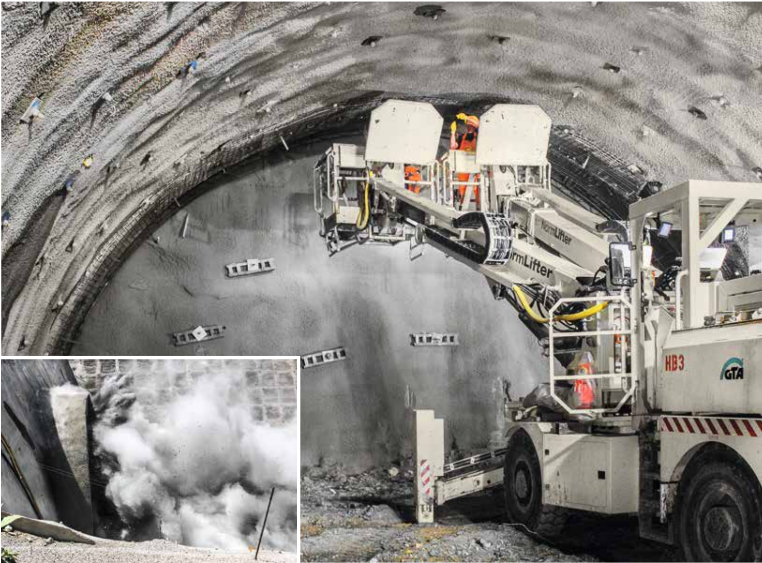
Sprengvortrieb im Tunnel
