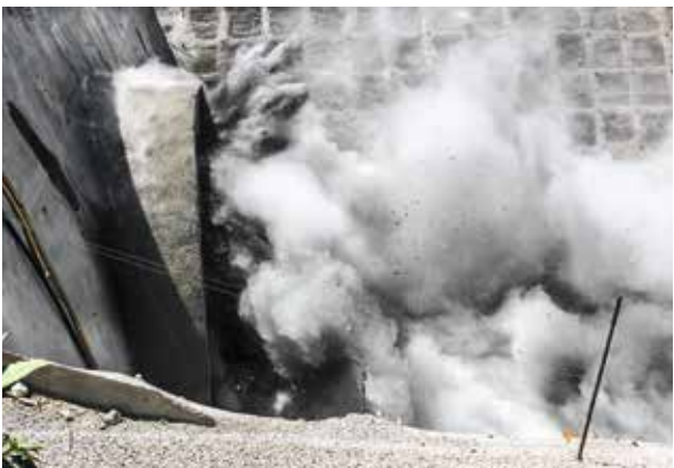
Sprengvortrieb im Tunnel
